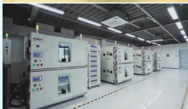
谱尼集团新能源检测技术中心和电性能及安全实验室
