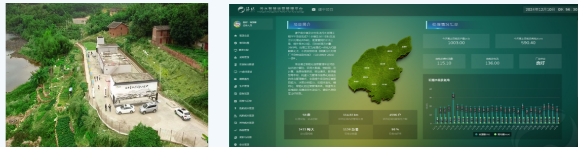
村镇污水项目及村镇污水处理智慧系统
