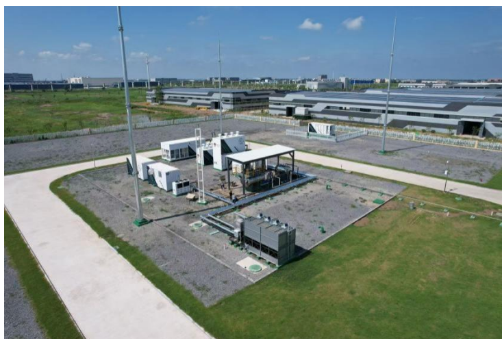
图：盐城大丰光储氢离网制氢项目
