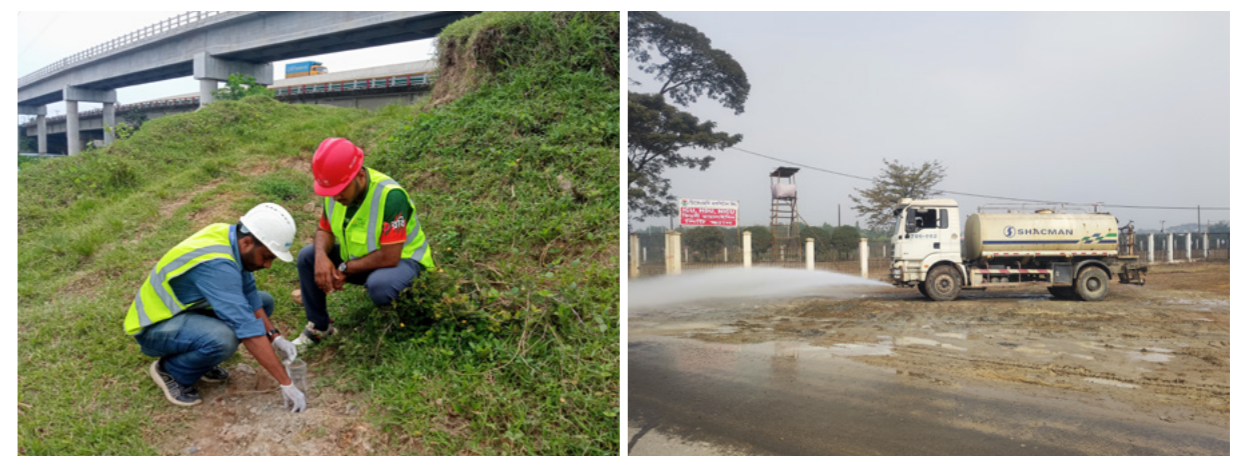
孟加拉达卡项目环境监测及作业现场
