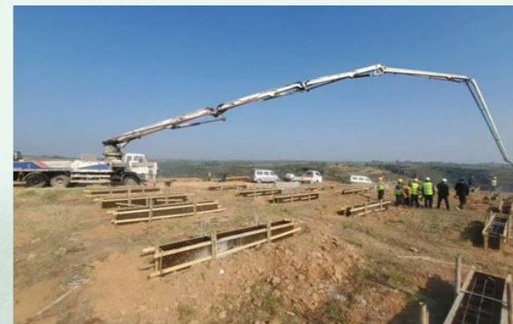
光伏施工现场
