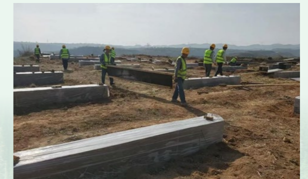
光伏工作人员施工现场
