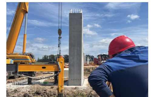
○ 桥梁下部装配化施工
