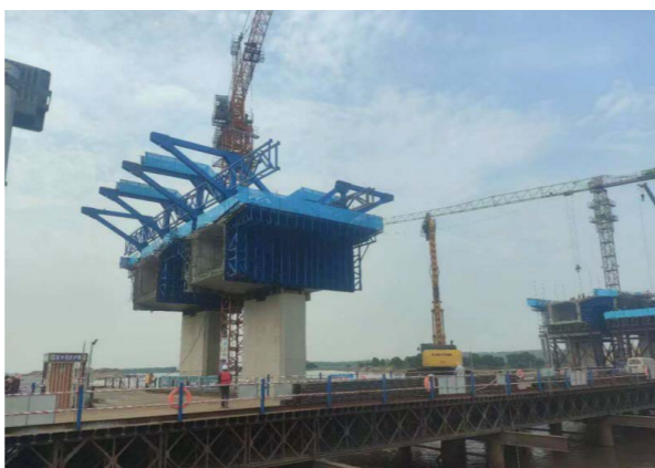
墩顶临时固结支座优化技术
