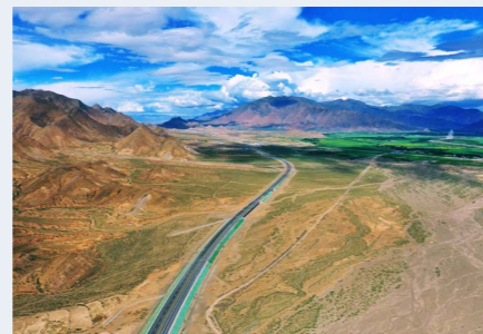
西藏日喀则机场高速公路
