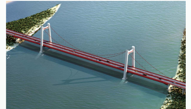
○ 哈尔滨都市圈环线松花江特大桥主桥
