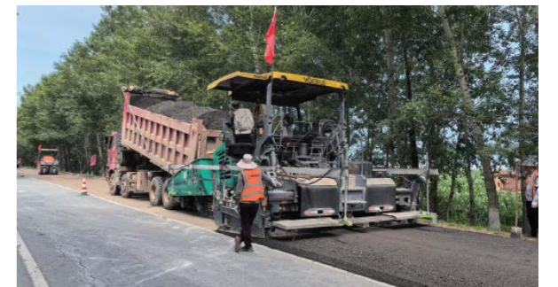
循环路面再生技术
