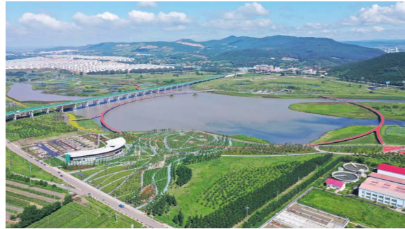
七台河市桃山湖生态环保水利综合治理项目
