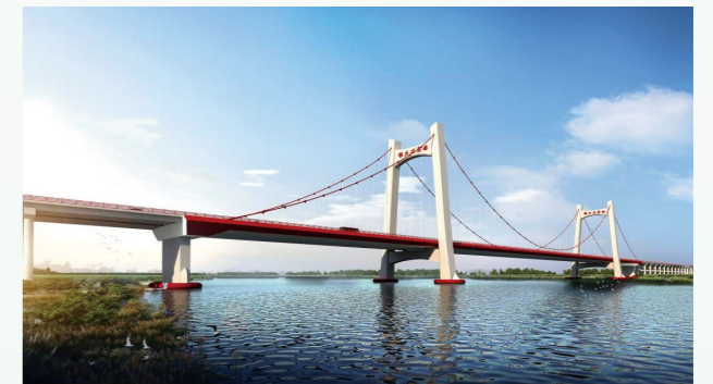
○ 哈尔滨都市圈环线松花江特大桥主桥
