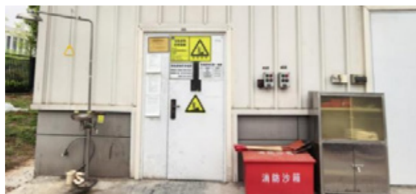
危险废物贮存场所
