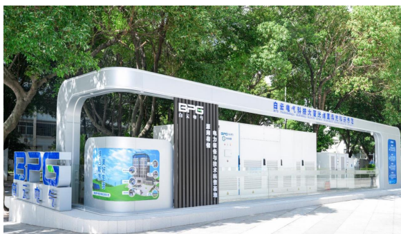
白云电气科技大厦智能楼宇“光储柔直充”示范工程
