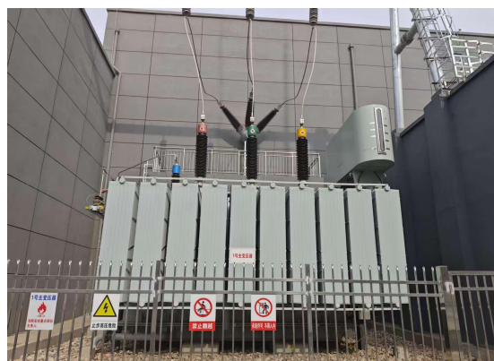
明蔚京西云计算数据中心(二期)项目
