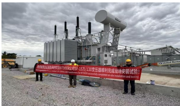
比特小鹿数据中心项目
