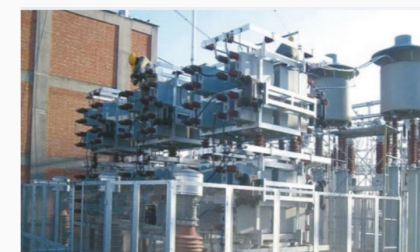
SVC(MCR、FC、TSC)中压静止无功补偿装置
