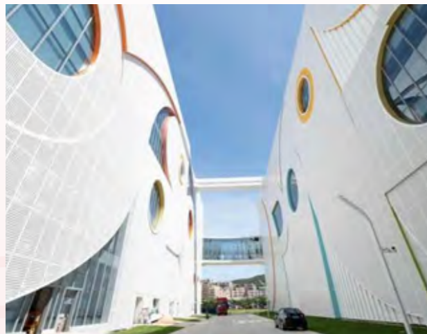
外部穿孔铝板与 LOW-E 双层中空玻璃幕墙
