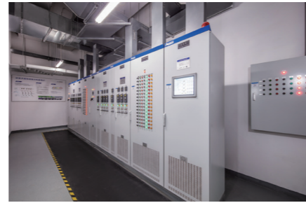
达实大厦EMC007中央空调节能控制柜
