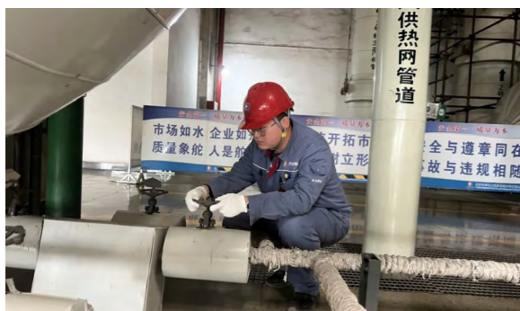
京玉发电开展冬季供热机组检修
