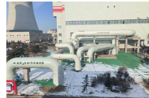
京宁热电完成汽轮机乏汽梯级利用供热节能改造
