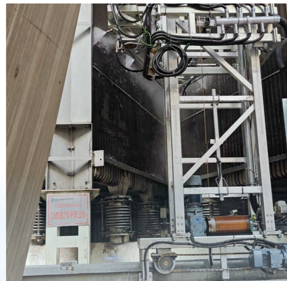
盛乐热电开展间冷却塔冷却三角自动冲洗应用研究
