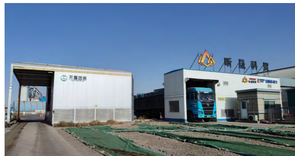
重型卡车换电站
