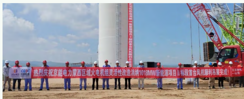
蒙西区域火电机组灵活性改造消纳 1018MW 新能源项目首台风机顺利吊装完成
