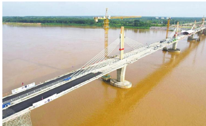
老泰第五友谊大桥施工现场
