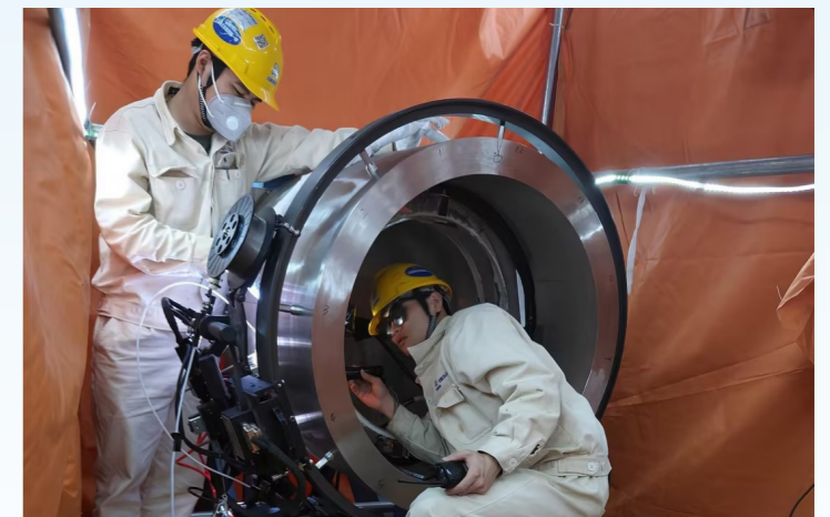
中核五公司积极探索新技术领域，自主研发主打产品——窄间隙 TIG 焊接机器人与管道全位置 TIG 焊接机器人
