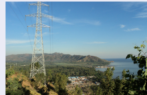
东帝汶国家电网工程
