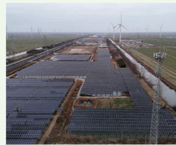
射阳港零碳园区渔光互补光伏发电项目
