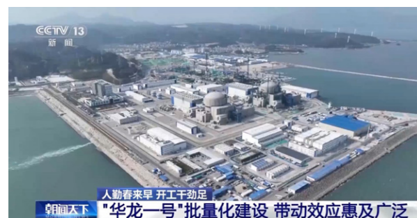
华龙一号——漳州核电项目建设现场
