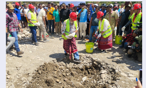
东帝汶大型农业灌溉工程开工
