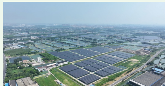
江苏常州郑陆 115.5MW 渔光互补项目
