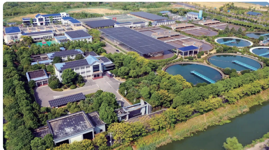
光伏发电项目
