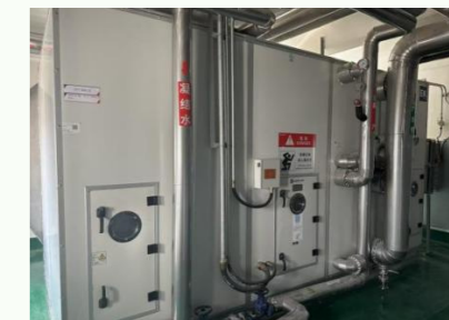
蒸汽冷凝水余热回收
