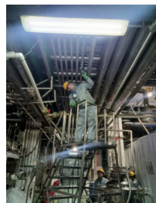
水路管线排查
