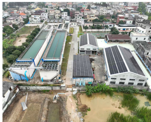
南头水厂光伏发电项目
