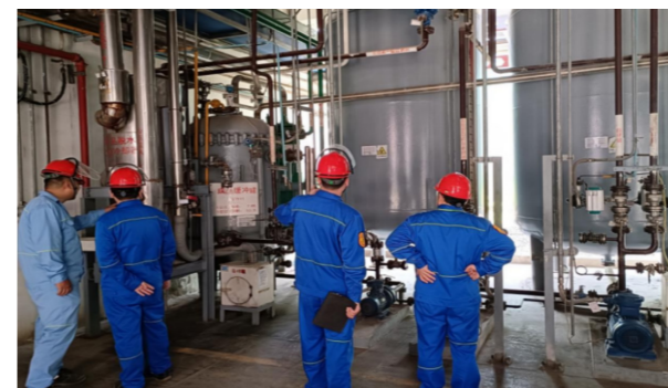
南通基地隐患排查
