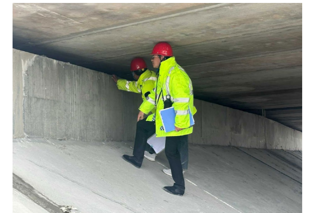
安全隐患排查检查现场
