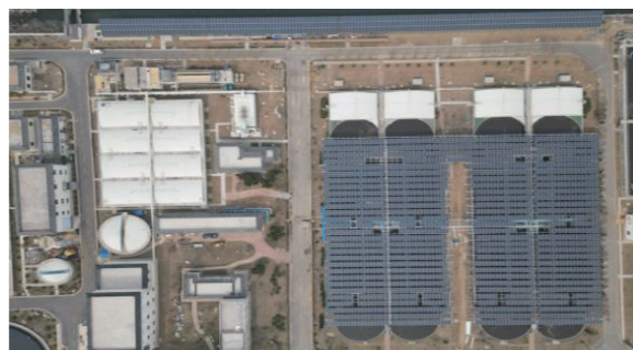
宁阳化工园区污水处理厂光伏发电项目
