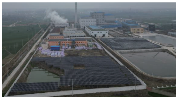
太和中晟污泥处置厂光伏发电项目
