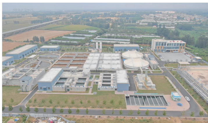
宁阳化工园区污水处理厂现场俯瞰图
