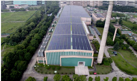
杭州某云计算数据中心项目
