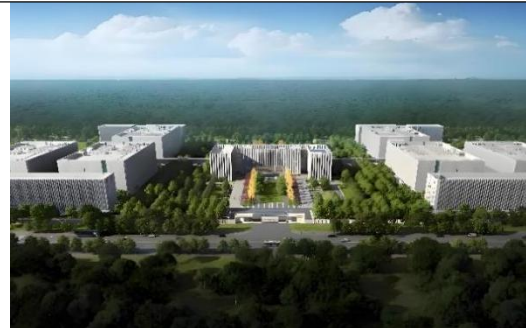
中国某行内蒙古数据中心
