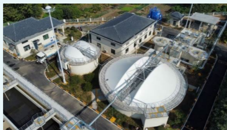
徐州市建邦不老河污水處理廠擴建工程
