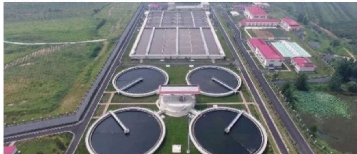
秦皇島海港區西部污水處理廠
