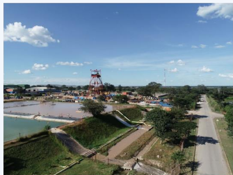
消耗 节能效果良好 为竖井提升 大量减少化石能源 鲁班比铜矿由斜坡道无轨运输改
