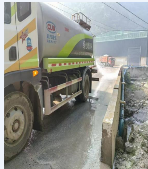
施工场地洒水车定期洒水 降尘抑尘
