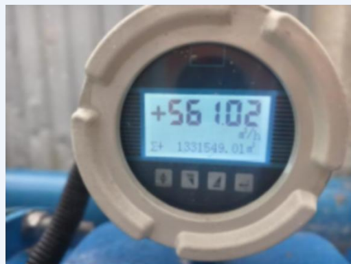
矿井水处理站安装进水口、出水口流量计及在线监测
