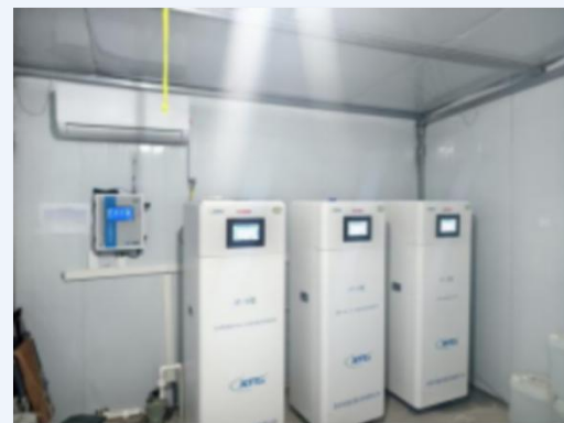
矿井水处理站安装进水口、出水口流量计及在线监测
