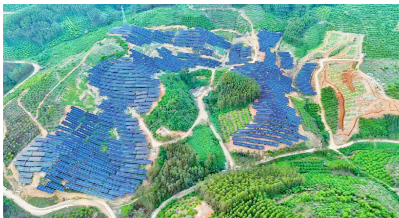
华南公司田阳那丹 50 兆瓦农光互补发电项目全容量并网，为当地脱贫攻坚成果巩固与乡村振兴提供有力支撑
