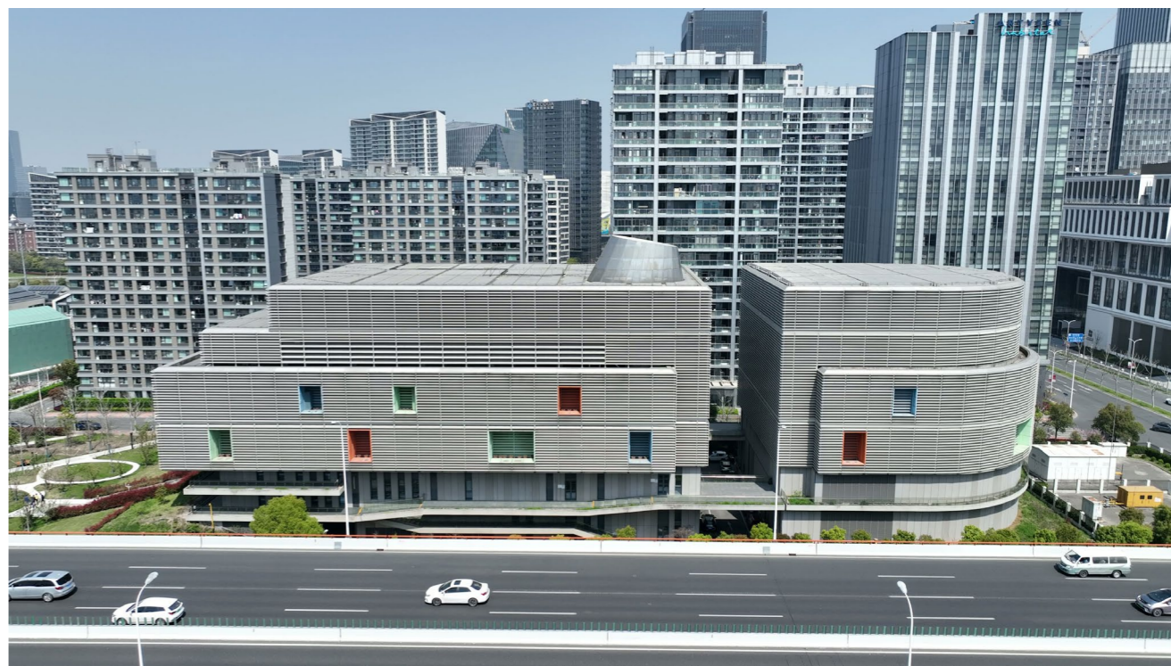
绿能公司前滩综合智慧能源项目通过技术创新和管理手段，为用户侧综合智慧能源高质量发展贡献力量
