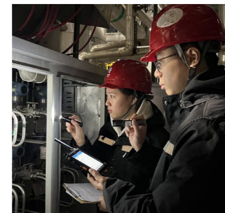
漕泾热电运行人员对易冻坏的户外热控设备进行监测
