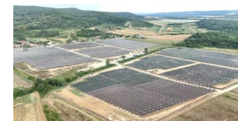
罗马尼亚 Prime 光伏项目
