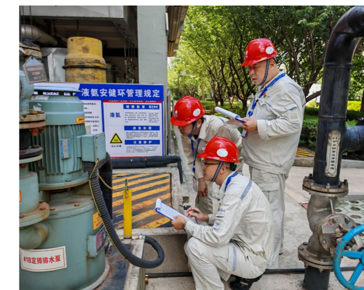
长兴燃机组织对所在区域的井坑、基坑、排水沟、构筑物 and 应急排涝设备排查，确保暴雨期间保供电可靠性
