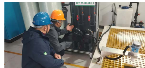
曲靖公司节前供水设施检查
