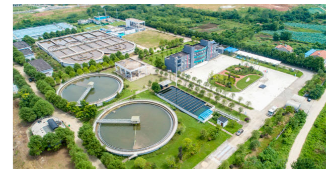
武汉阳逻污水处理厂
