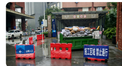
建筑垃圾处理
