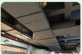
空调系统 - 风管改造
