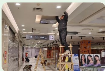
照明设施改造
