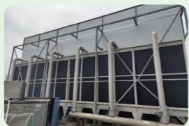
空调系统 - 主机改造
