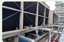
空调系统 - 主机改造
