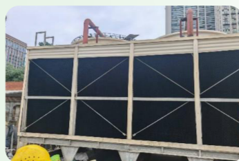
空调膨胀水箱改造
