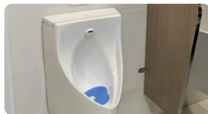
泛悦 Mall·南湖店卫生间及设施改造
