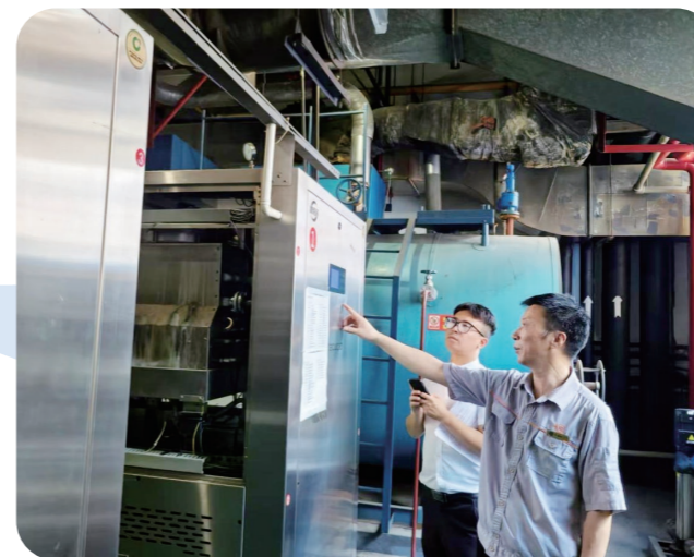
● 圣爵菲斯大酒店配电房、锅炉房、动力机房安全检查。
