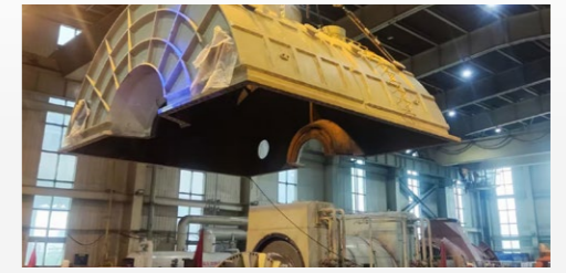
2×300 兆瓦低碳节能综合利用升级改造项目
