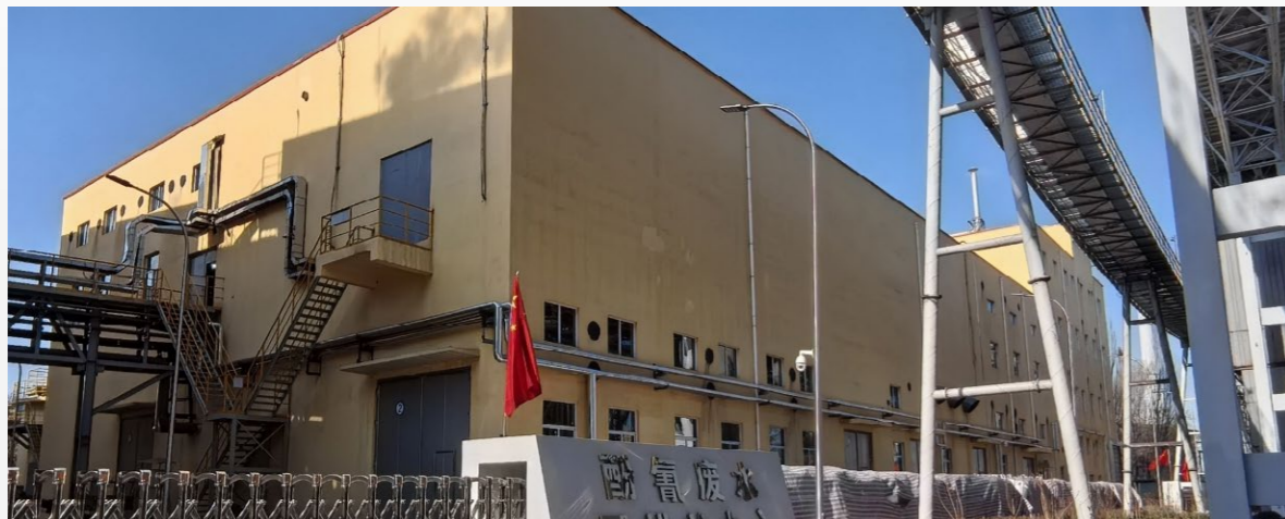
太钢不锈焦化酚氰废水零排放项目
