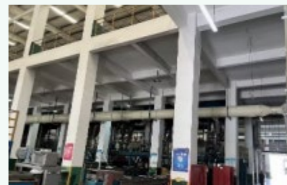
改造后：管道更换，收集风速已达标
