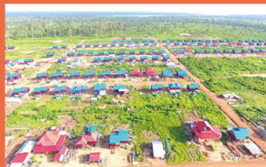
桑河二级水电站移民村
