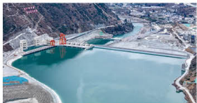
硬梁包水电站
