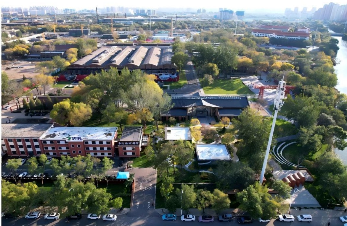
▲津一·PARK：天津市第一机床总厂改造更新前后
