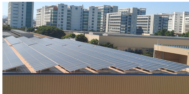
公司翔安产业园屋顶光伏铺设
