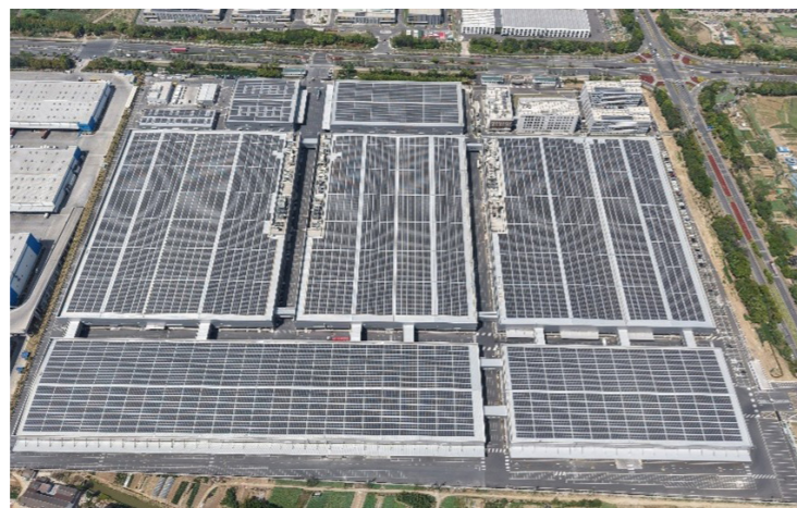
弘元光能 35MW 分布式光伏项目
