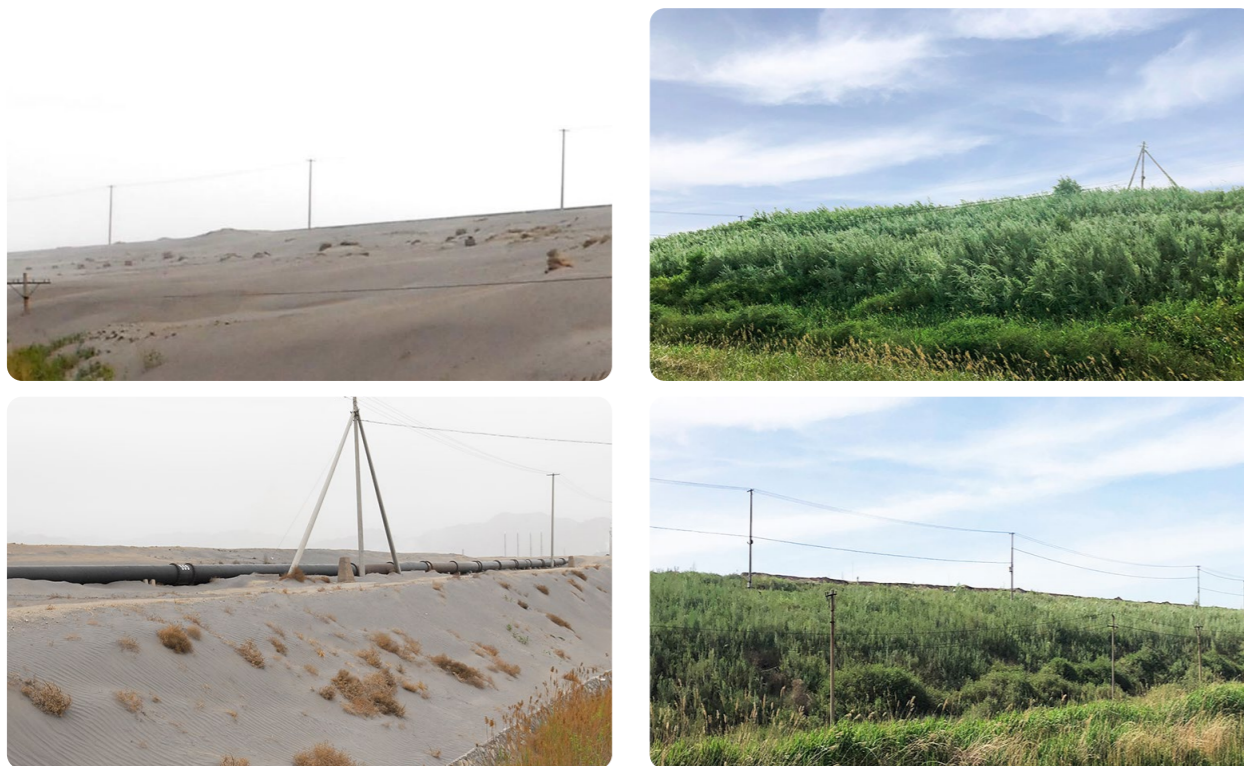
包头钢铁集团尾矿坝治理前
