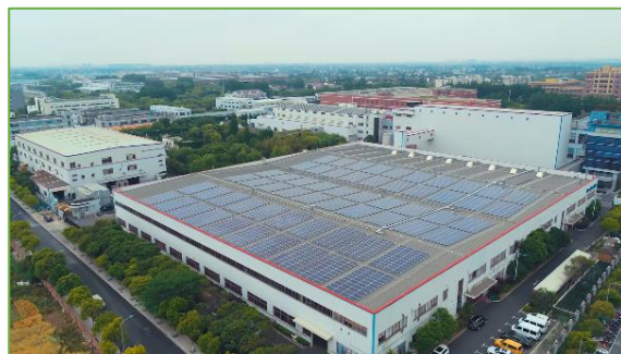
图注 屋顶自建屋顶光伏电站项目
