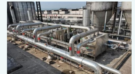
黄舣酿酒生态园蒸糠机 WSR 节能技术改造项目
