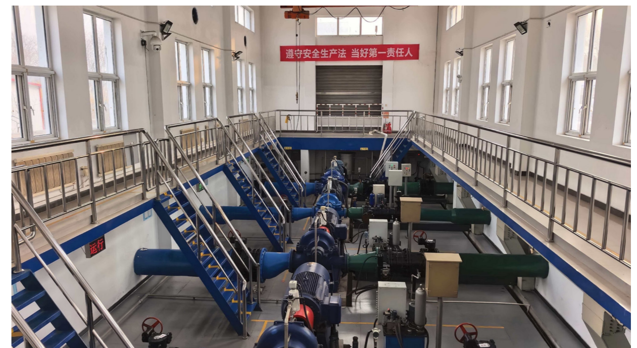
所属子公司宜达水务采用高效节能送水泵，有效实现能源节约
