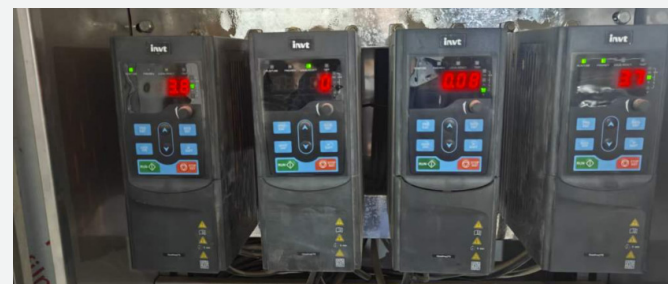
供水系统改造改
