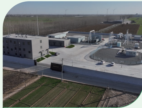
聚能风电场升压站运营
