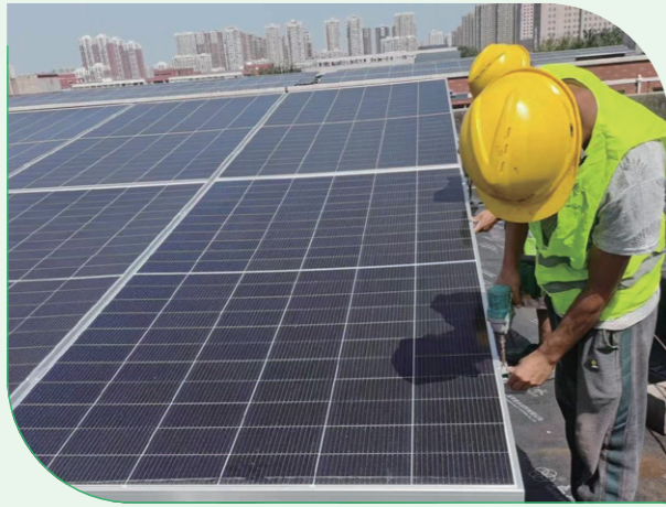
石家庄学院分布式光伏项目 (二期) 光伏组件安装
