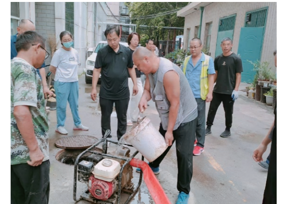
积水抽排作业现场
