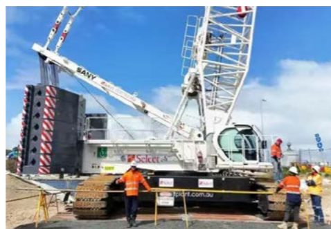
澳大利亚的弗里曼特尔桥梁改造项目中 SCC3200T 履带起重机
