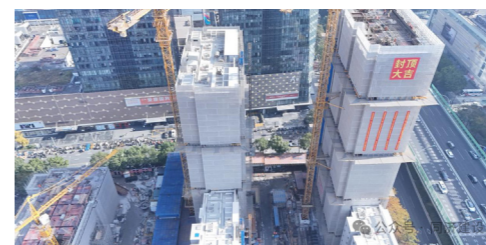
2025年11月30日结构封顶
