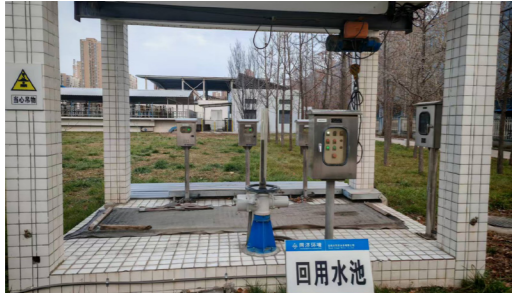
宝鸡高新区污水处理厂中水回用水池
