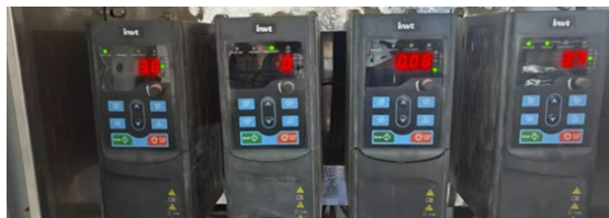
供水系统改造改造
