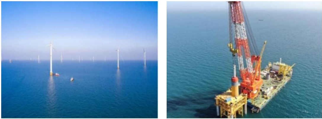
亨通华能临高海上风电项目
