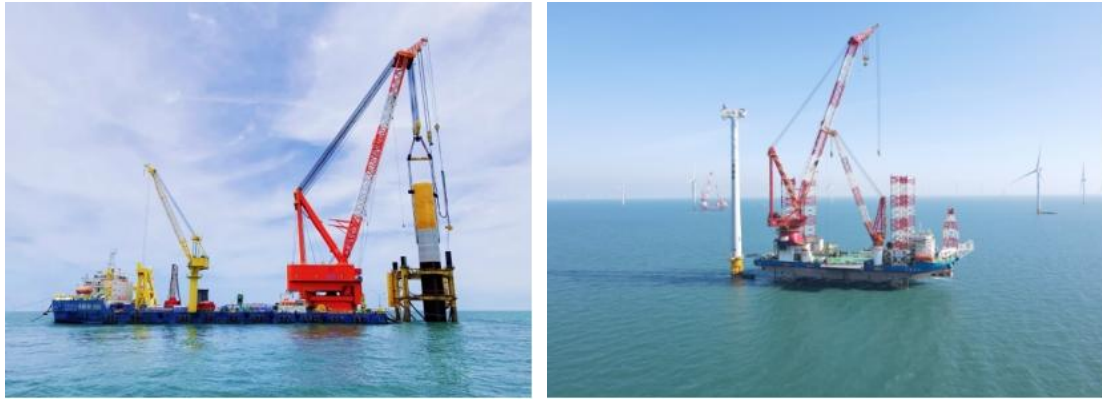
亨通参与海南省“十四五”期间首个全容量并网发电的海上风电项目建设
