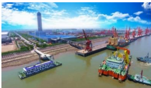
亨通国家电网舟山项目
