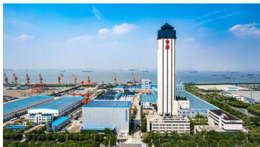
苏州常熟亨通国际海洋产业园
