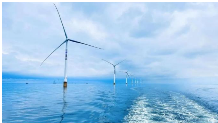
亨通参建的全球首个“海洋牧场+海上风电”融合试验示范项目
