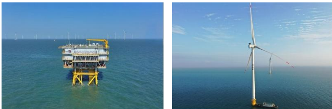
亨通参建的申能海南 CZ2 海上风电示范项目
