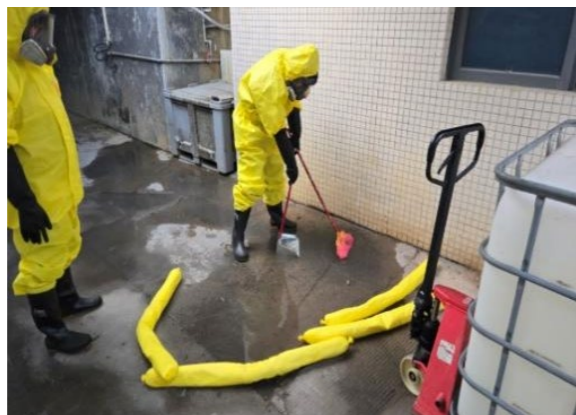
对泄露废水进行围堵、收集及地面冲洗
