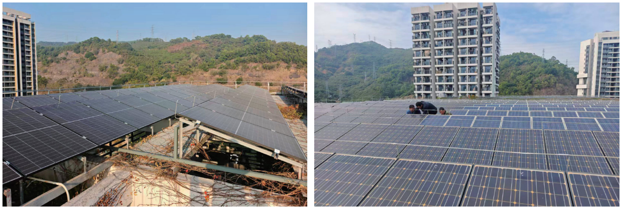
建科大楼屋顶光伏发电系统改造后实景图 (左：更新后的光伏设施；右：新旧光伏设施阵列)
