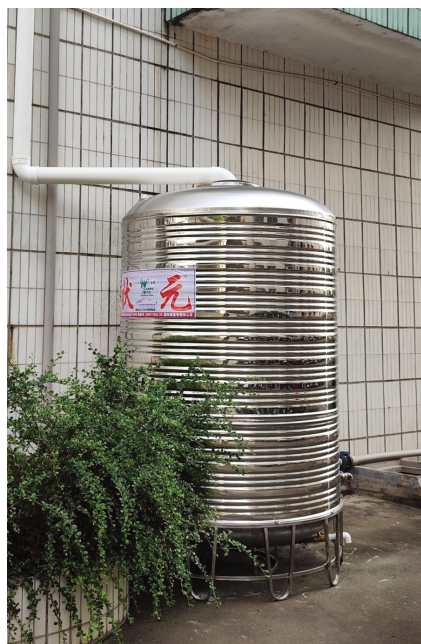
廠區屋頂設置兩座3噸蓄水塔用以收集雨水，並將其回用於景觀綠化與環境清掃
