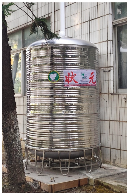
廠區屋頂設置兩座3噸蓄水塔用以收集雨水，並將其回用於景觀綠化與環境清掃
