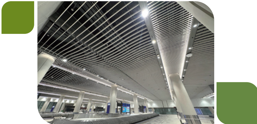
HKIA Terminal 2 Expansion Works – Design, supply and installation of main roof baffle ceiling system 香港國際機場二號客運大樓擴建工程－設計、供應及安裝主天幕條子天花系統
