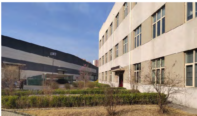
洞车公司园区内建设光伏项目
