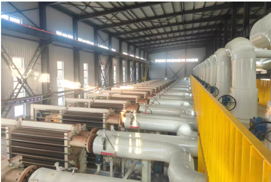
沈东热源厂隔压站板式换热器
