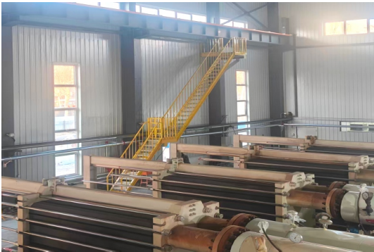
沈东热源厂隔压站板式换热器
