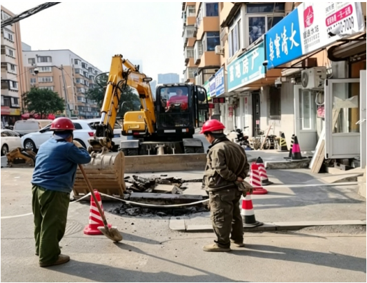
顺通路38-1号漏点挖掘
