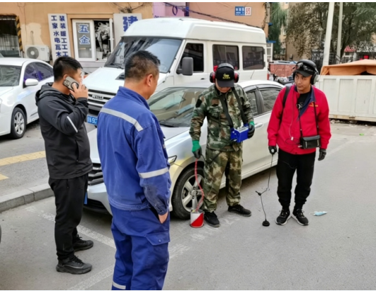
2066#站气体测漏现场
