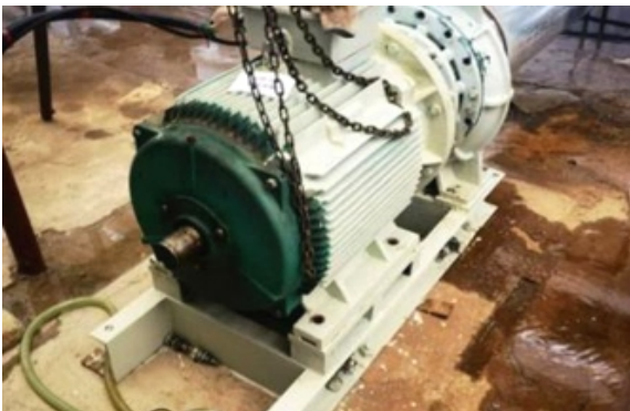
故障抢修现场
